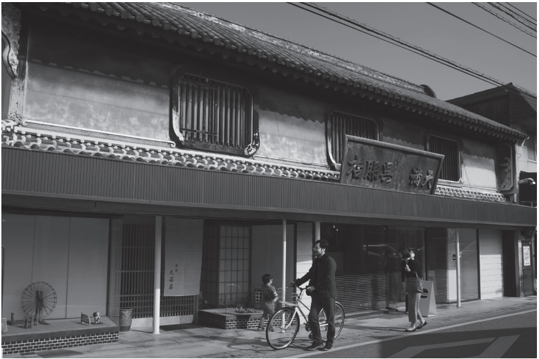
fig.5-2 写真左側は江戸時代から続く呉服屋。右側部分を改修してサンドイッチ店を営業している。
