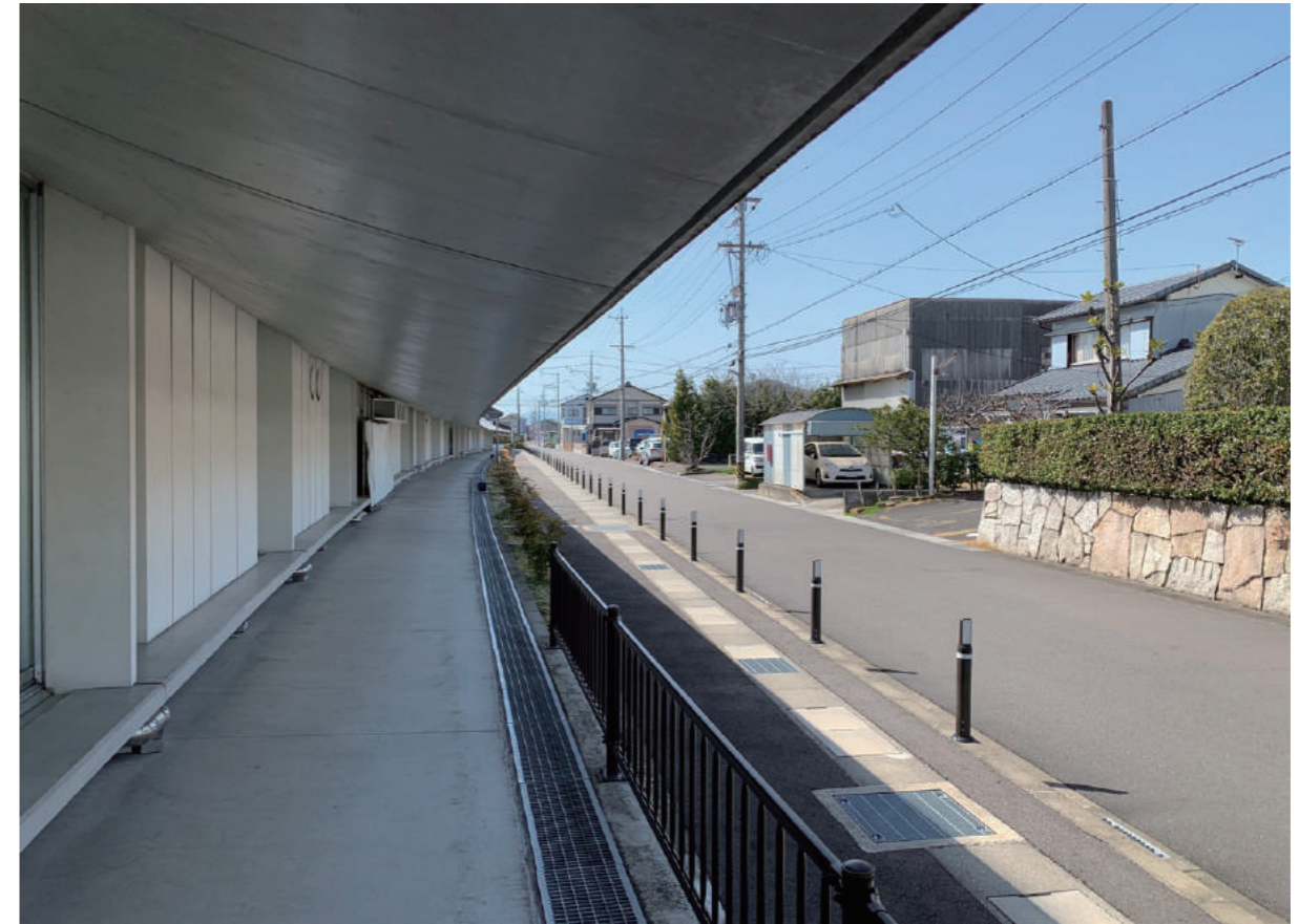
fig.3-f1 軒下空間（建物北側）
