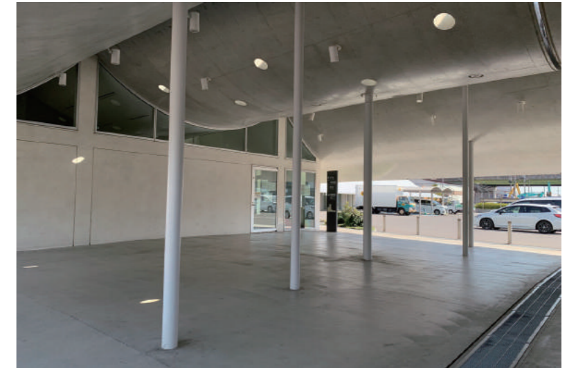
fig.3-f6 軒下空間（中央公民館・保健センター間）
