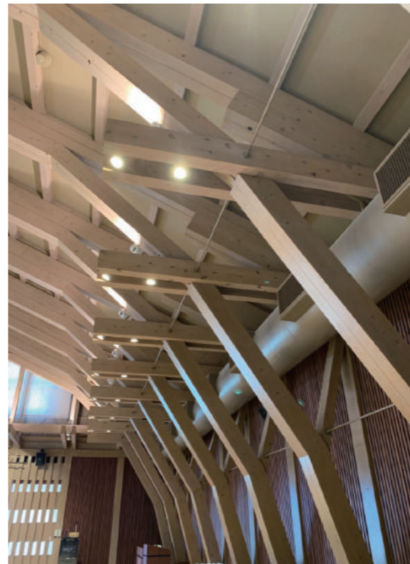
fig.3-a5 スギ材が用いられた現し
